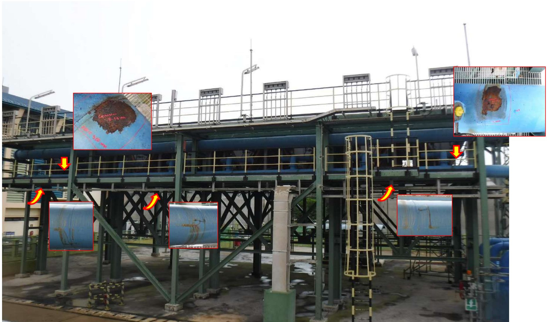
ภาพแสดงบริเวณที่พบสีเสื่อมสภาพ และเกิด Corrosion
